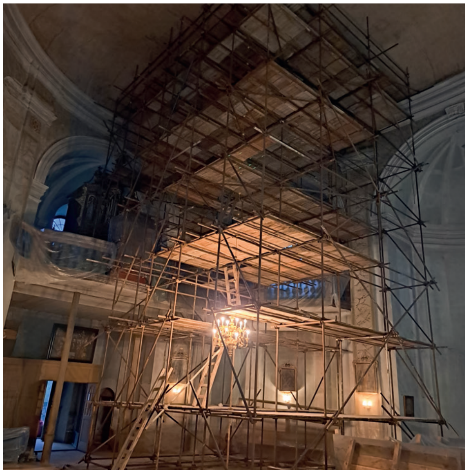
Fotka z aktuální obnovy vnitřního stropu v kostele sv. Barbory v Otovicích.
